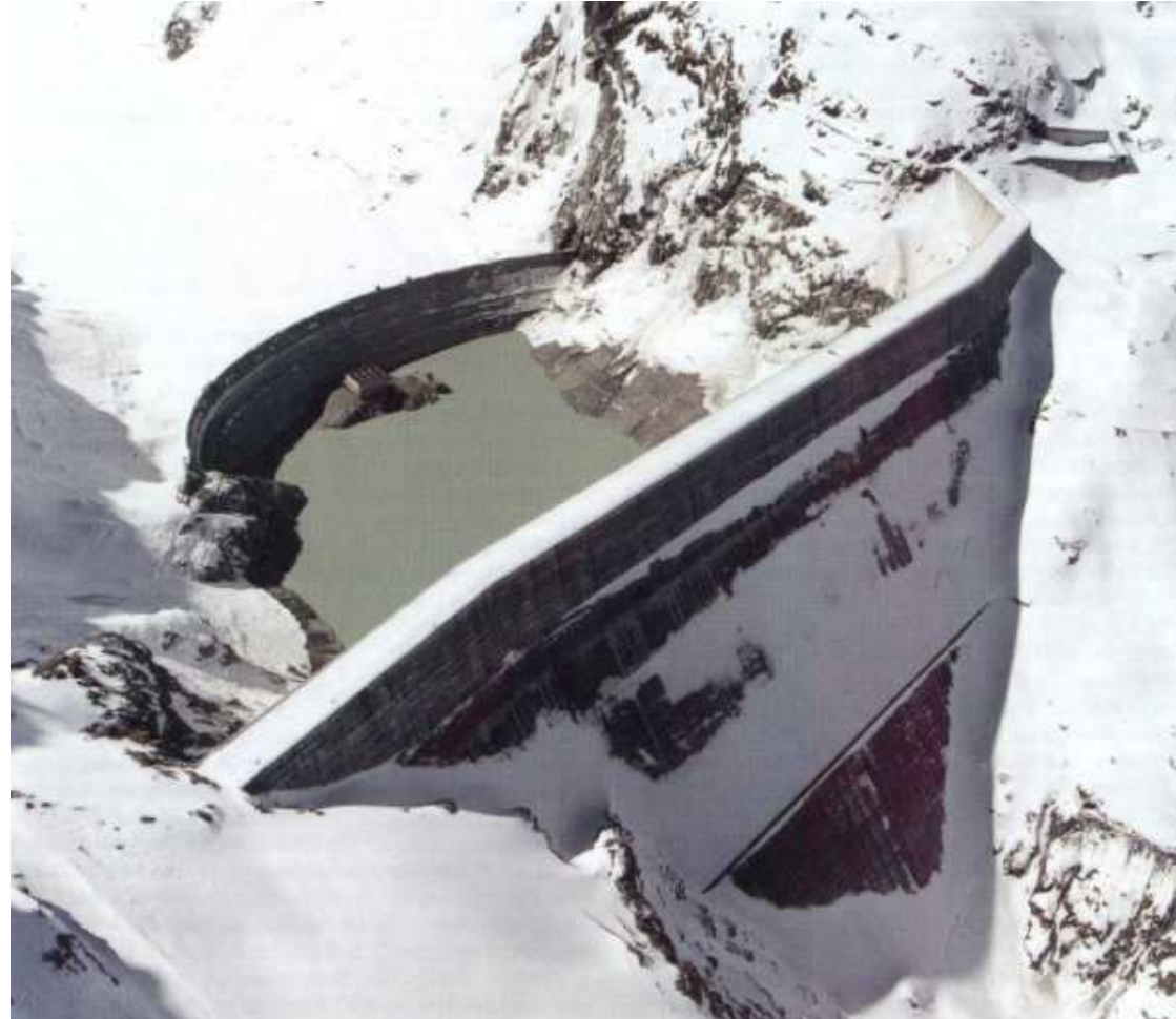
Diga Grande Dixence (1961-1972)– Svizzera – A gravità in cls - h=285m
