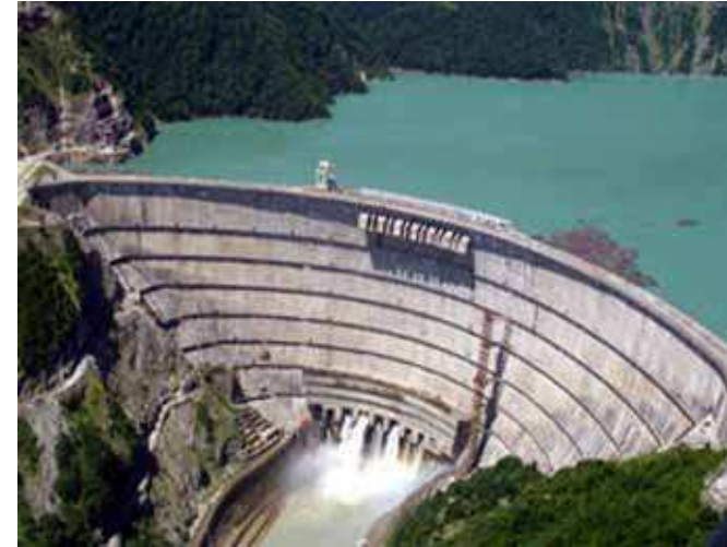
Diga sul fiume Inguri – Georgia – h=271.5m
