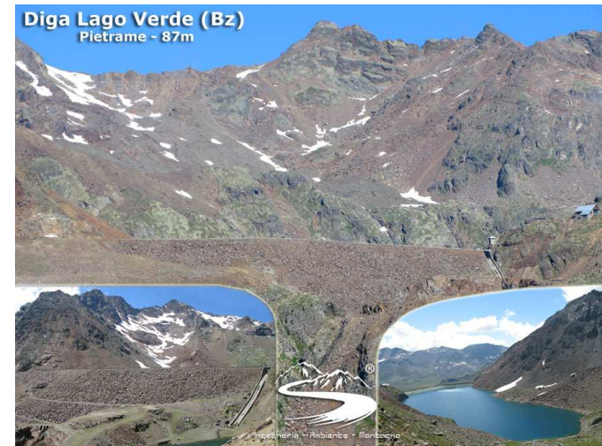
Diga di Lago Verde – Trentino Alto Adige – h=87m
