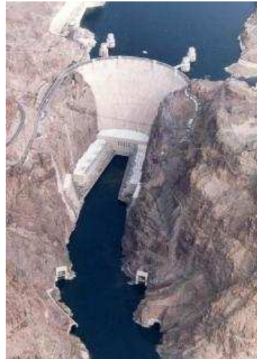
Diga di Hoover (anche conosciuta come Boulder Dam-Diablo) situata nel Black Canyon del fiume Colorado, sul confine tra lo stato dell'Arizona e del Nevada negli USA - h = 221\text{ m} .
