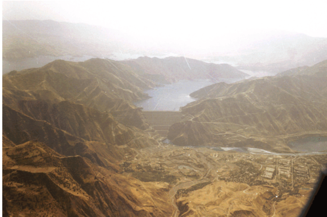
Diga Nurek sul fiume Vakhsh (1961-1972)– Tagikistan - In terra, zonata, con ricoprimento in pietrame sui paramenti - h=300m
