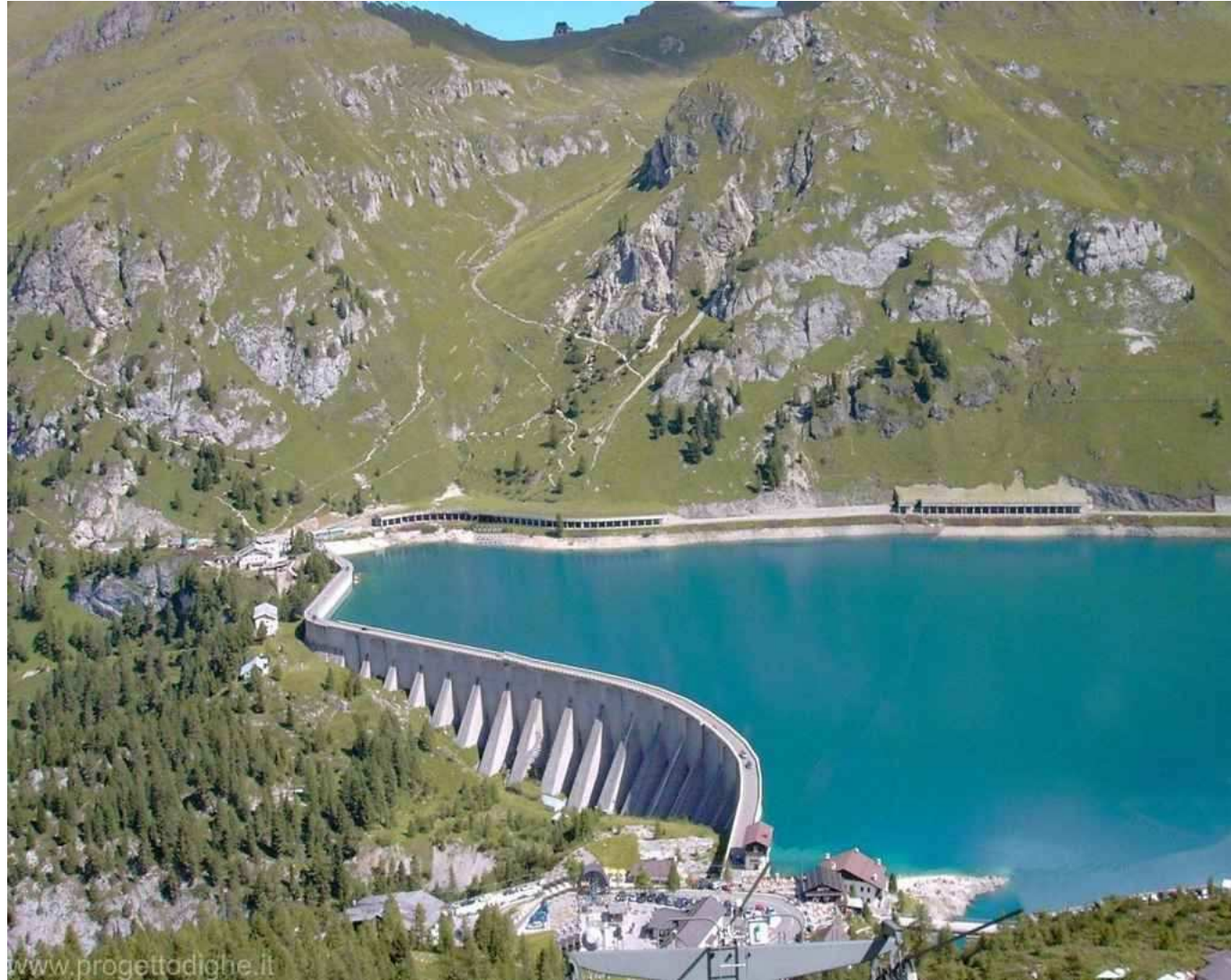
Diga sul fiume Avisio – Trentino Alto Adige
